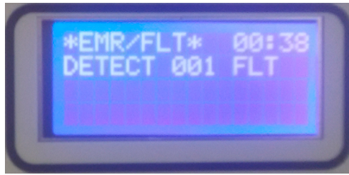
Figura 25) Videata in stato di Guasto
